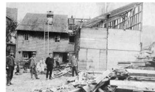
Abbruch des zweiten Langgebäus um 1909 mit gestrickten unteren Geschossen und Dachgeschoss in Fachwerkbauweise.
