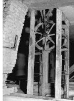
Paternosterlift für den Ziegeltransport
