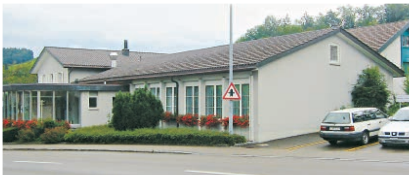
Personalhaus «Rössli» in Etappen von 1949 bis 1954 erbaut.
