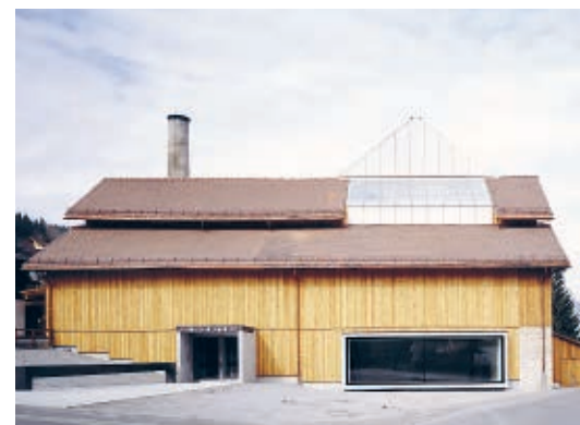
Ostansicht um 1970 mit offener Fassadenschalung und nach dem Umbau mit Lärchenschalung.
