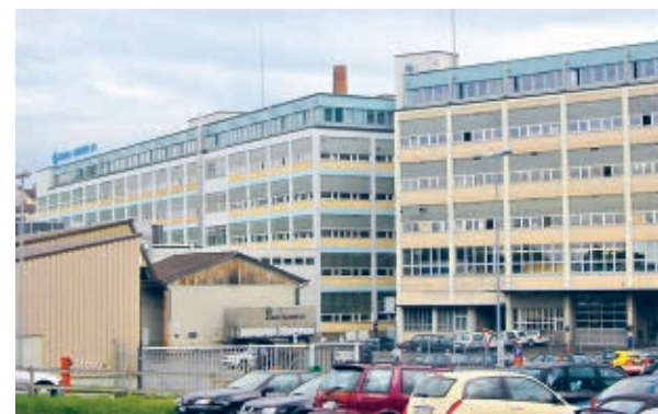
Oben: Rasterfassaden aus Beton-, Glas- und Backstein-elementen und einer Aufstockung um ein Geschoss aus den Jahren 1984 und 1991.
