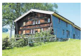
Tätschdachhäuser wurden früher mit von Steinen beschwerten Holzschindeln gedeckt, daher die flache Dachform.
