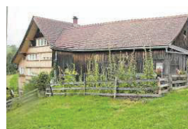
Beim Kreuzfirshaus, dem klassischen Appenzellerhaus, ist der Stall traufständig links oder rechts angebaut.
